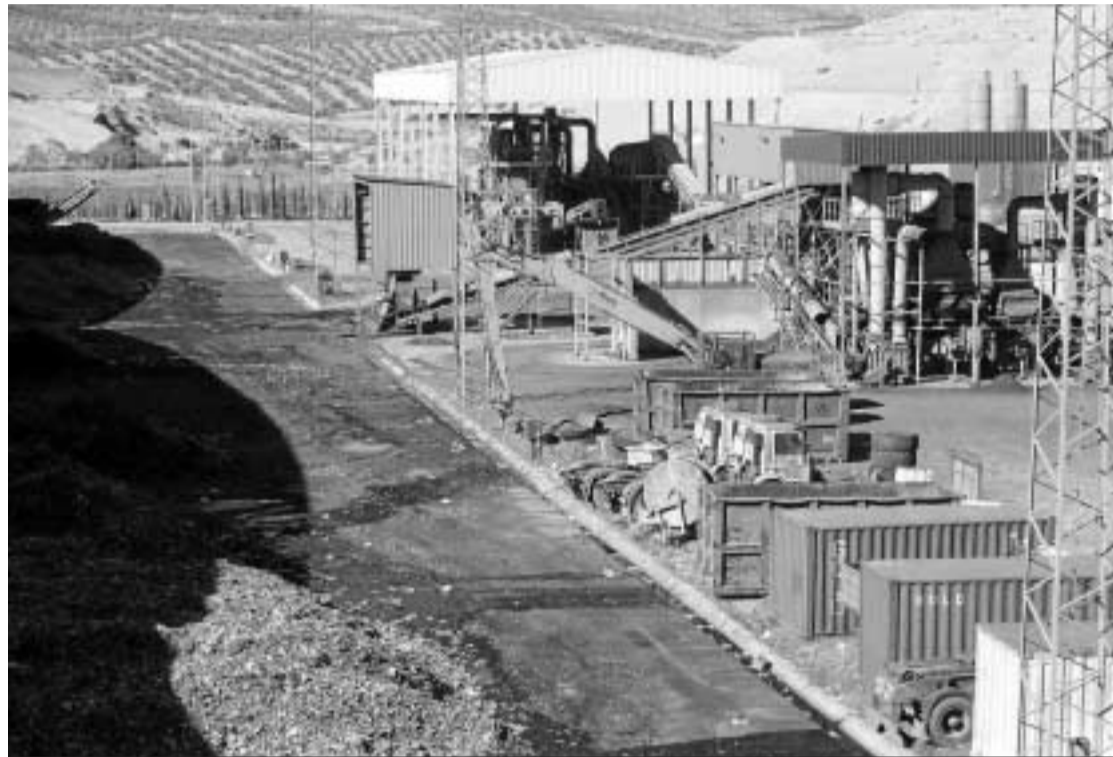
Vista de la planta Loma de Manzanares, en Alhendín, donde se tratan los RSU de Granada.
