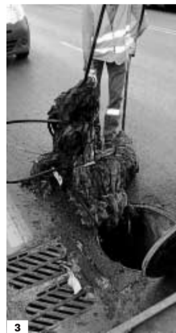
1. Biofactoría Sur de Granada, ubicada en el Camino de Purchil, una de las dos plantas depuradoras de agua de Emasagra. 2. Las toallitas de váter enredadas. 3. Extracción en una alcantarilla de un bloque formado por toallitas.
