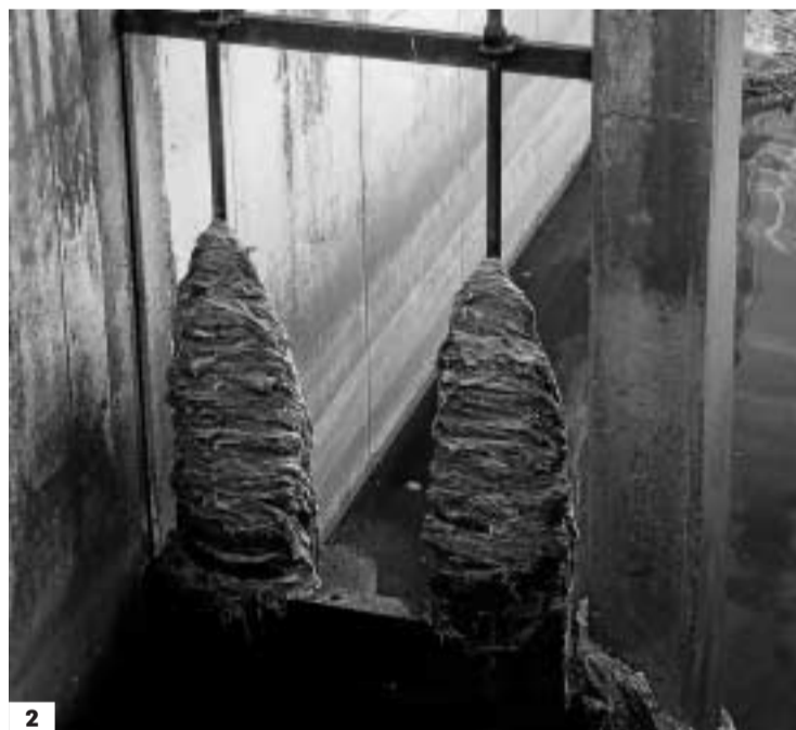
1. Biofactoría Sur de Granada, ubicada en el Camino de Purchil, una de las dos plantas depuradoras de agua de Emasagra. 2. Las toallitas de váter enredadas. 3. Extracción en una alcantarilla de un bloque formado por toallitas.
