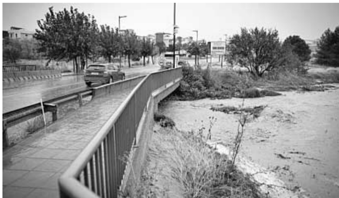
Crecida del arroyo que pasa por Otura.
